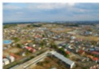
解体工事前イメージ （富岡町：夜ノ森地区）
