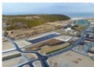
解体工事後イメージ （楢葉町：竜田駅周辺）
